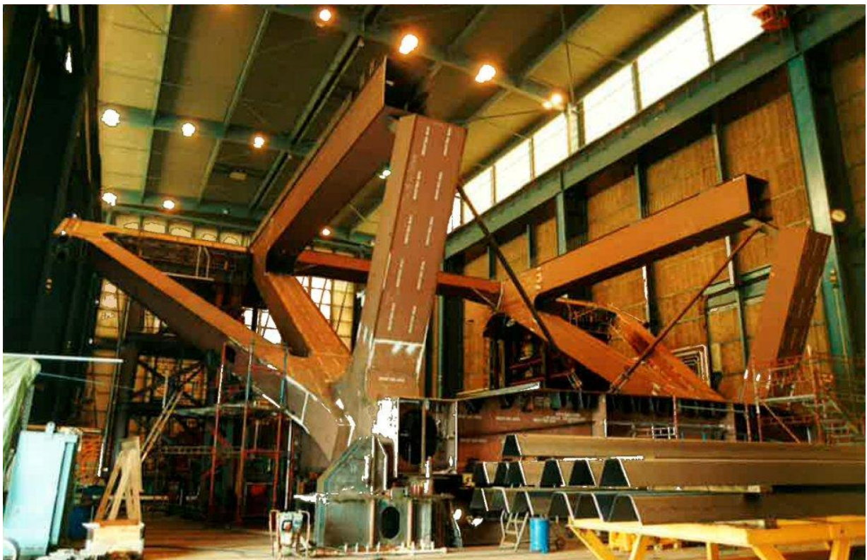
Slutmontage av 20 meter sektion.
