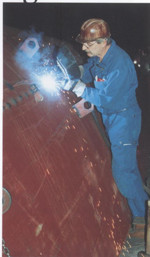
–Det blir nog en stabil åat, för här är enormt med brickor, järn och långor, säger plåtslagaren Gerts Svensson.
