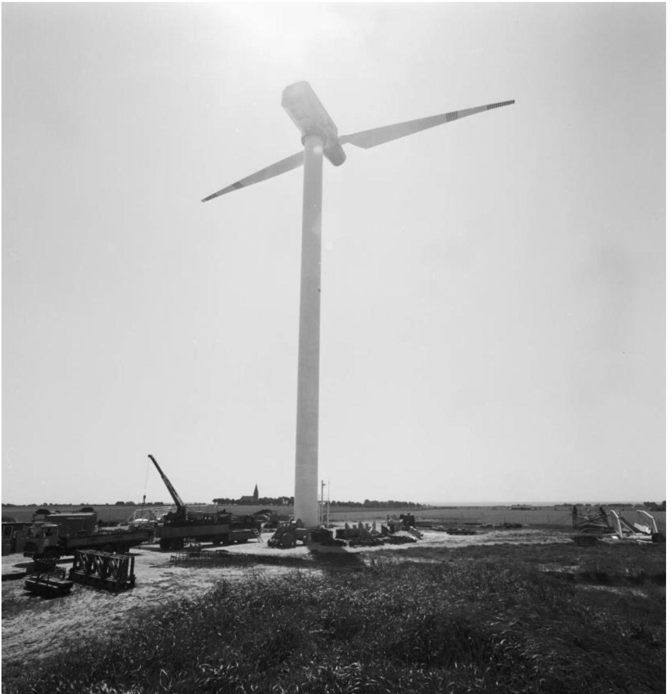
Vindkraftverket i Maglarp
