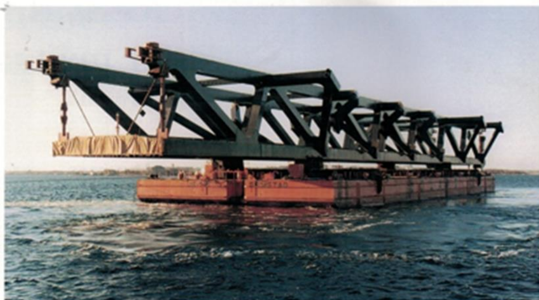
En 140 meters girder på väg till Malmö.
