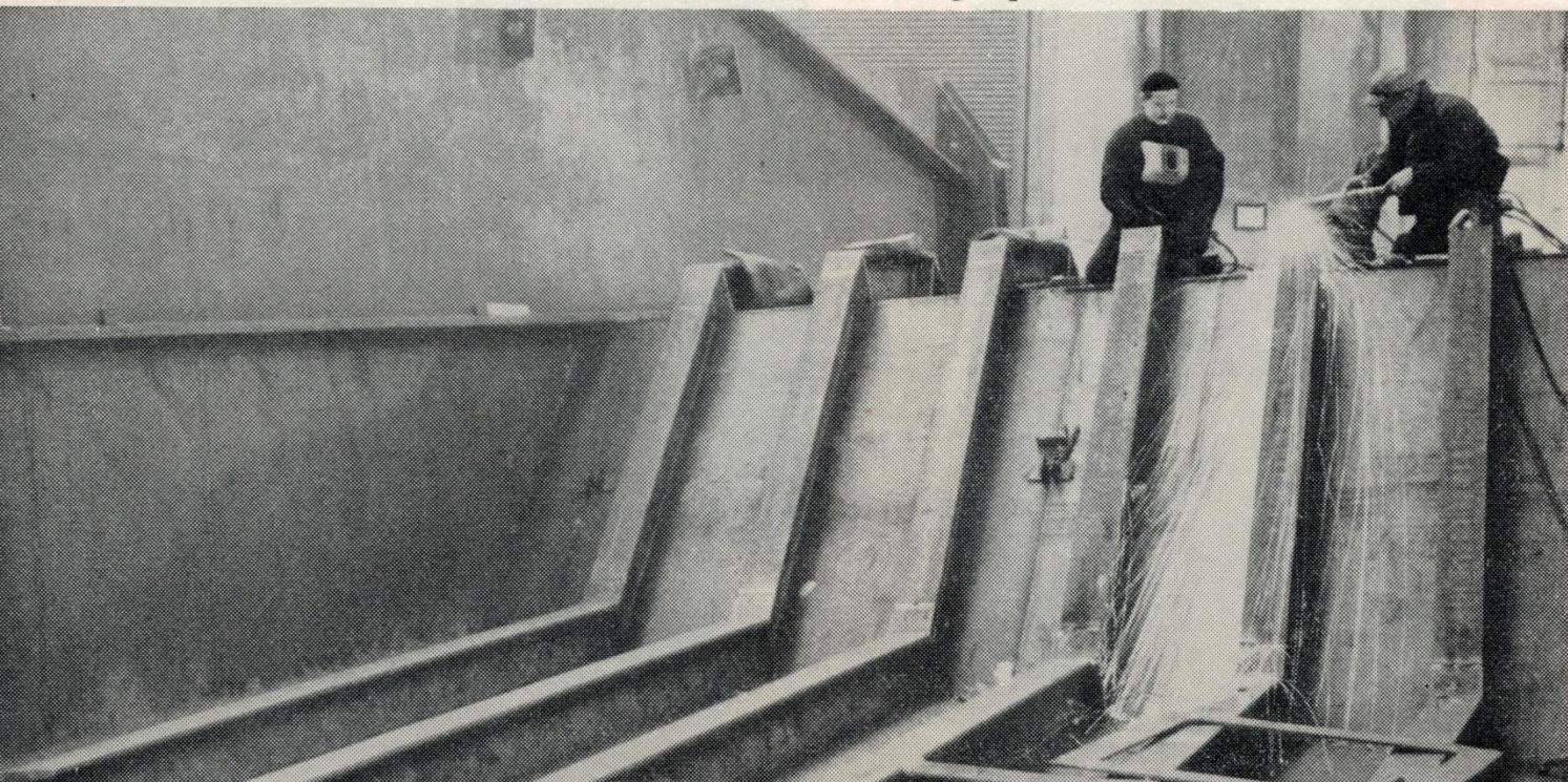
■ Flottningsluckan under sammansättning i pannverkstaden.
