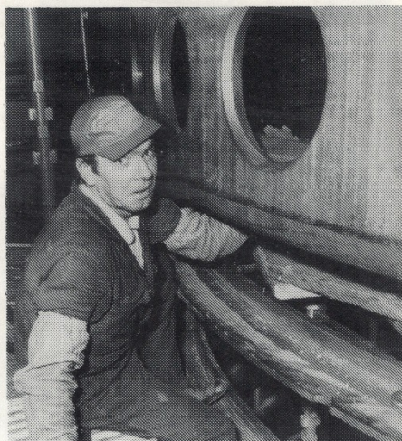
Tommy Malmberg är en av svetsarna som utför ett kvalificerat svetsarbete i 120 gr värme.
