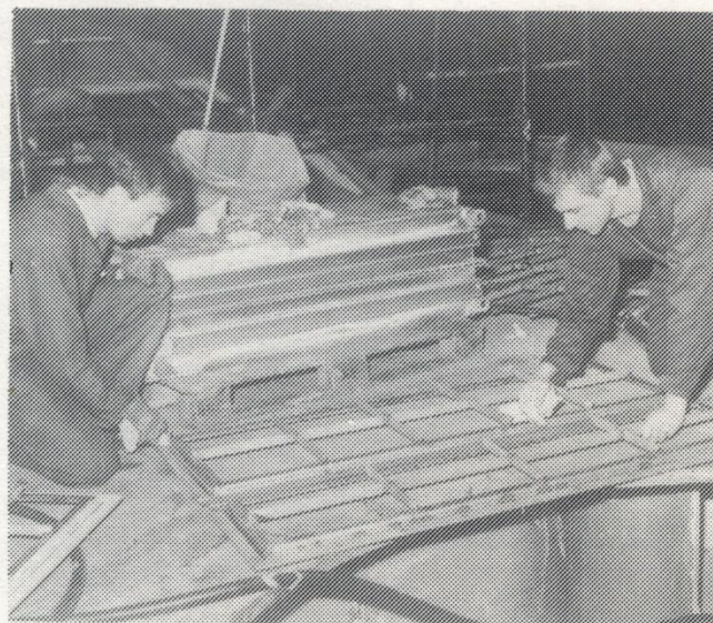
Ola Johansson och Patrik Johansson från filareverkstaden förbereder galler till luftintagen.
