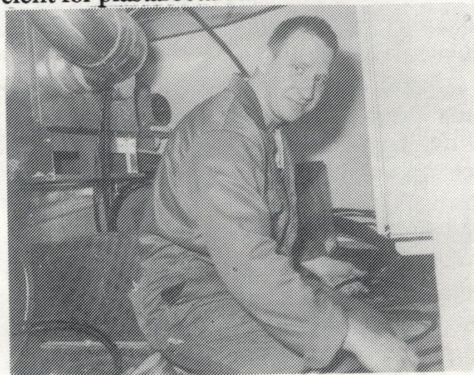
Sune Eliasson, elektriker, utför installationer i fläktrum.
