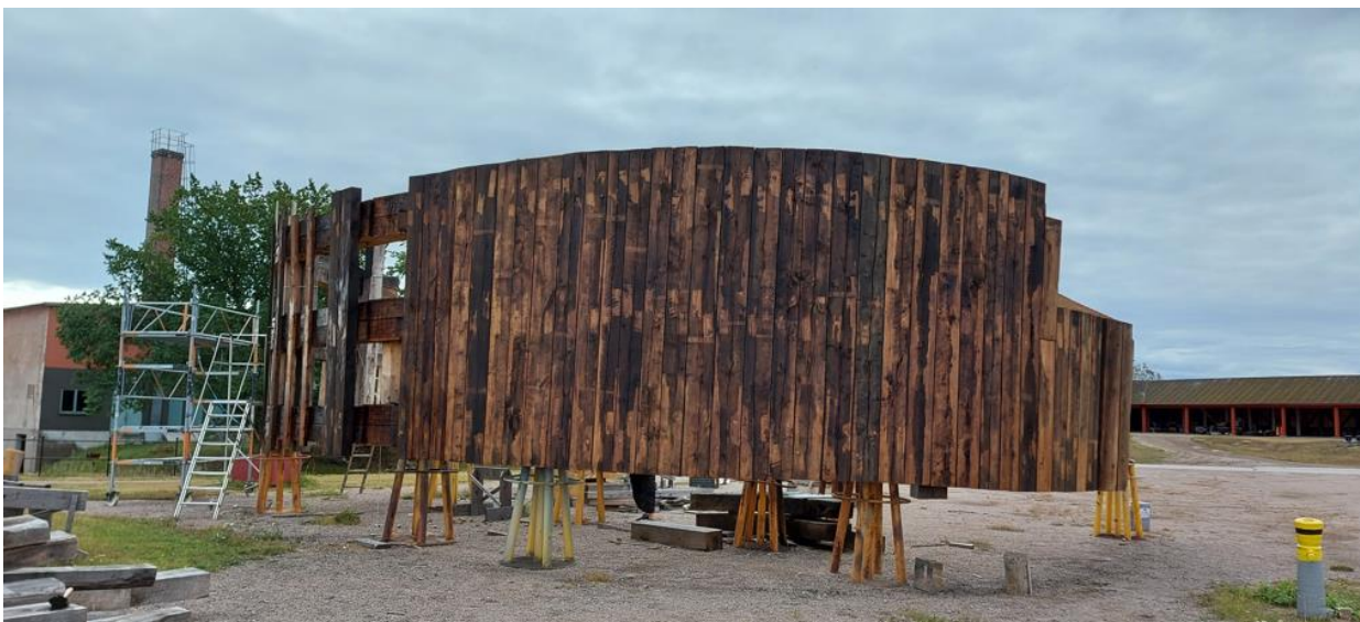
Spantsektionen sedd från utsidan, nu behandlad med trätjära
