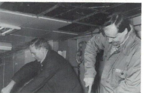
Lars-Erik Danielsson och Bengt Lind utför återställningsarbeten efter installation av brandspjäll i köksventil.
