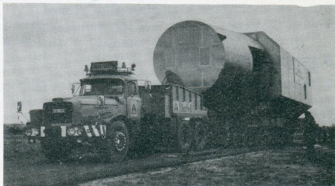
På väg över den elkabel som så småningom skall mata kraft från vindkraftverket.
