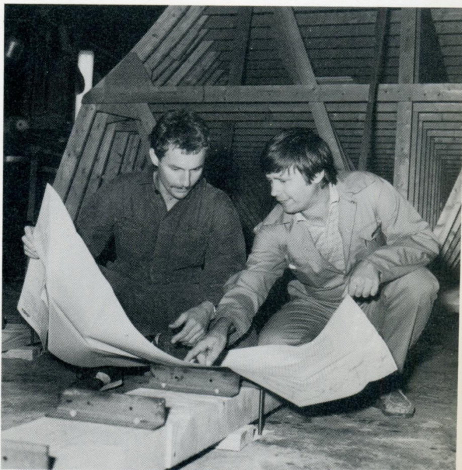
Tomas Kjellsson och Arne Törnström studerar här detaljerna kring uppbyggnad av ribbspantformen.
