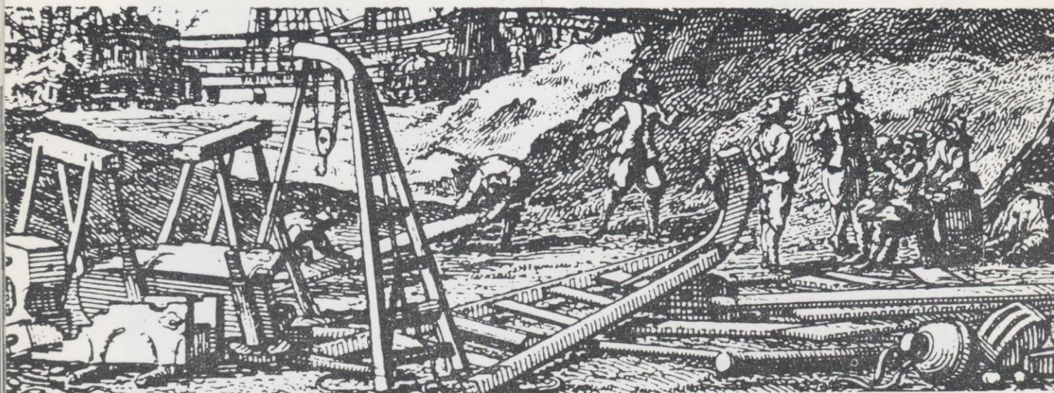
Varvets äldsta mobilkran såg ut så här. När lyftet var slut togs kranen ner och bars bort till nya lyft. Ur Suecia Antiqua 1692.
