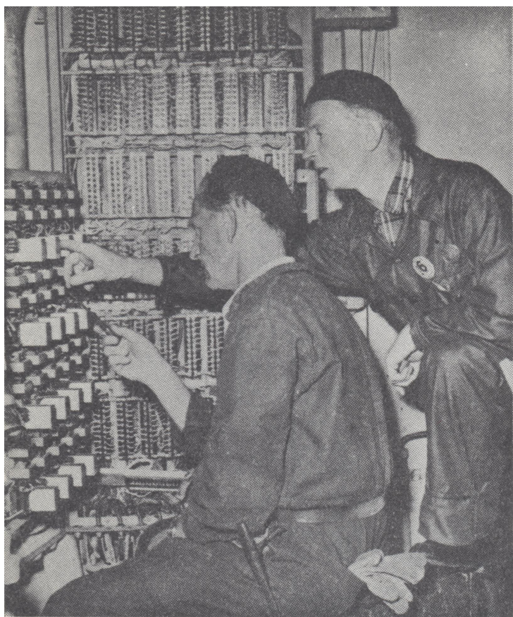
Fartygsinstallationsavdelningen omfattar ett 90-tal man - Sven Sverlinger och Paul Ström som får representera dem är på bilden i arbete med kopplingslådorna till en radaranläggning.
