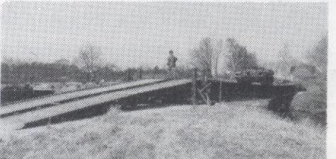
Efter att hitre ramp och klaff monterats är bron klar att användas för en stridsvagn med vikt upp till 65 ton.
