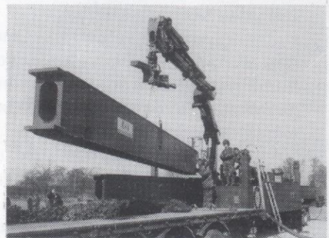
Hopsättning av lanserbalk...
