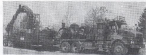
Dragbil med semitrailer lastad med lanseringsutrustningen...
