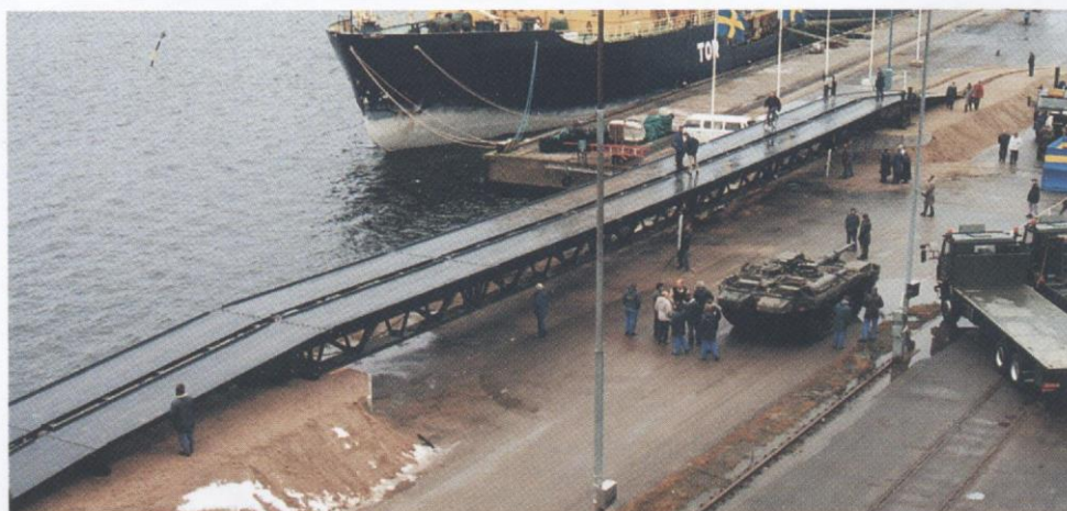
Bron har en spännvidd om 48 meter och läggs ut på 75 minuter.
