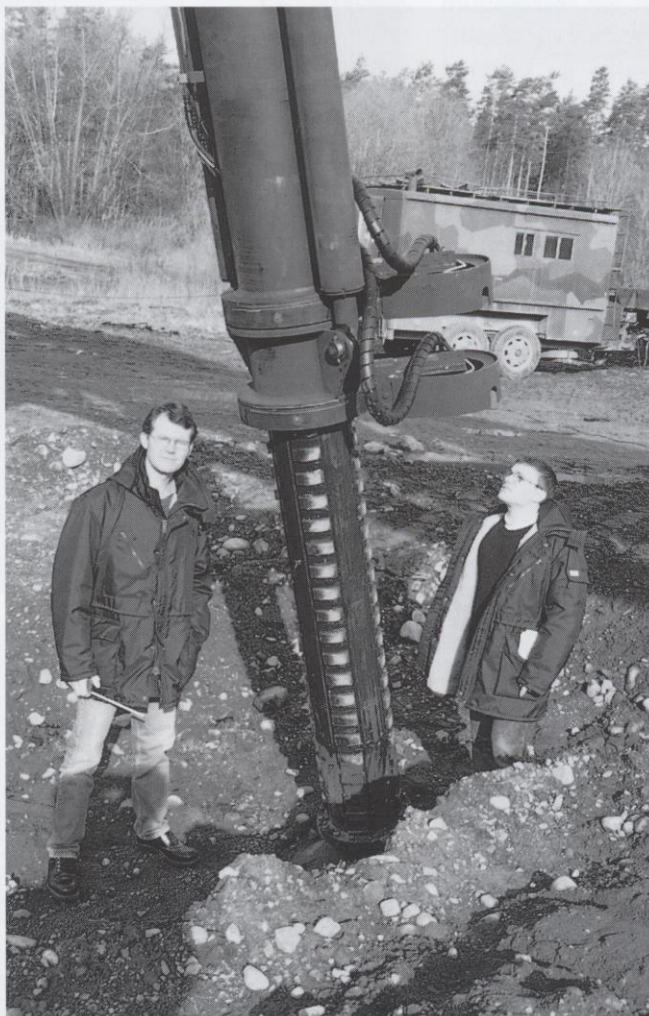
Konstruktörerna Hans Håkansson och Dan Knutsson inspekterar sin konstruktion i fält. Här intill ett av stödbenen.
