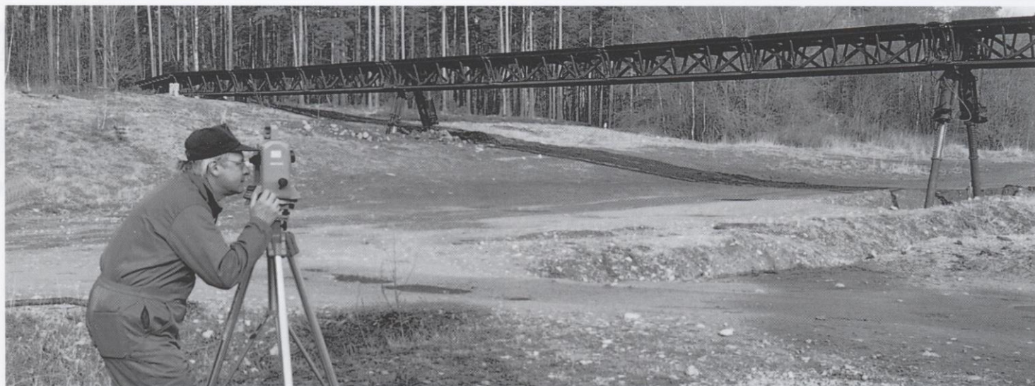
Kennerth Hansson kontrollerar eventuella stödsättningar i bron efter trafikering.
