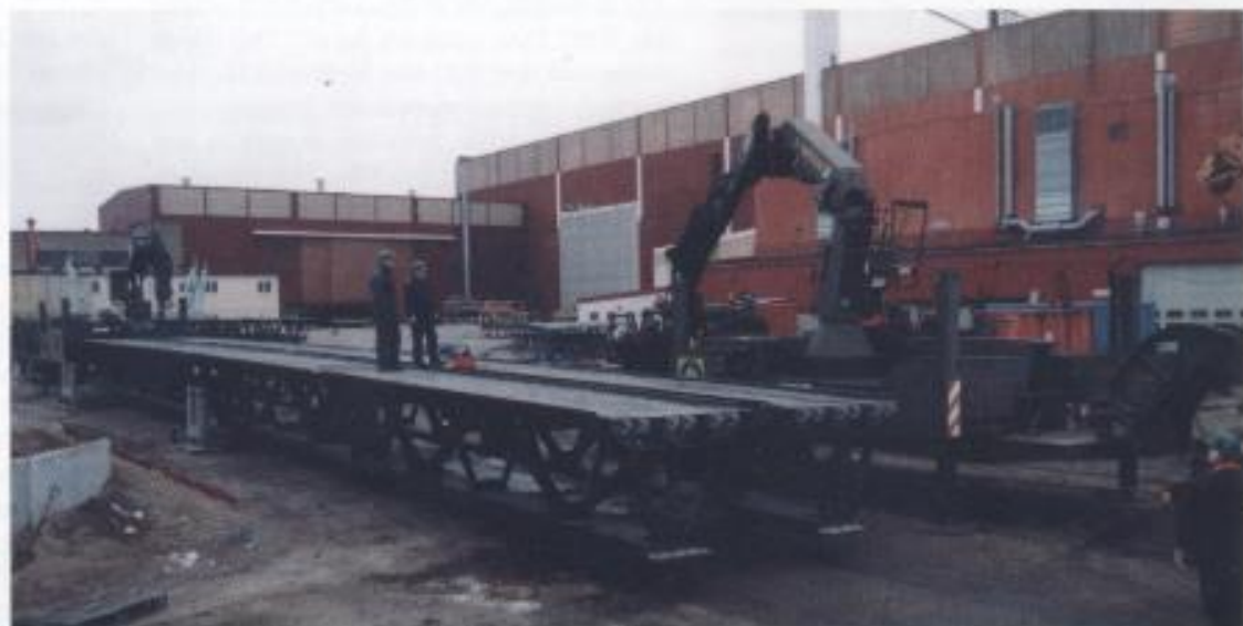
Prov pågår nu med komponenter till 200-metersbron.
