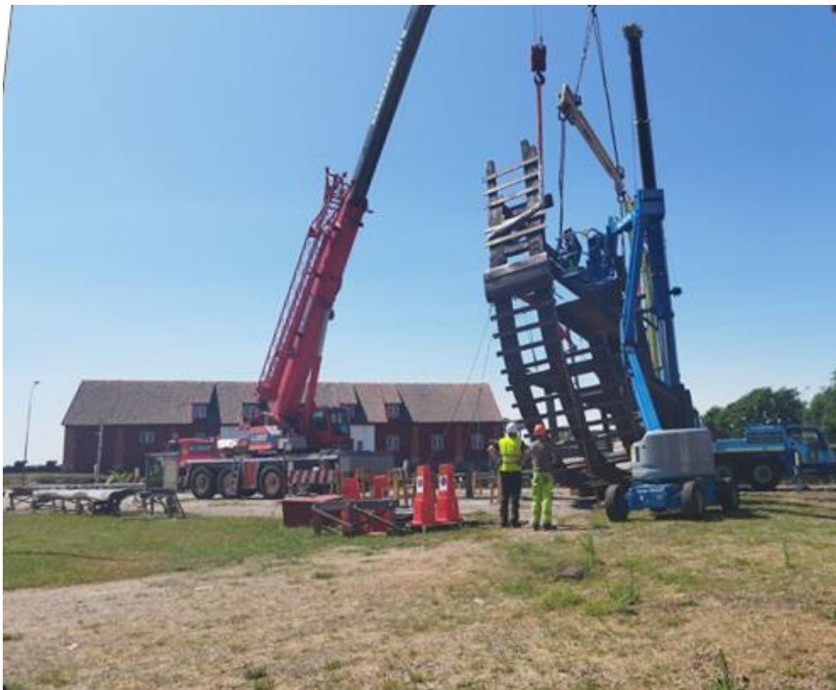
Spantsektionen reses med hjälp av tre mobilkranar
