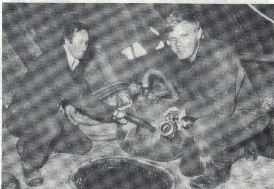
Leif Albertsson och Bengt Olbin förbereder inför provtryckning av tankar.
