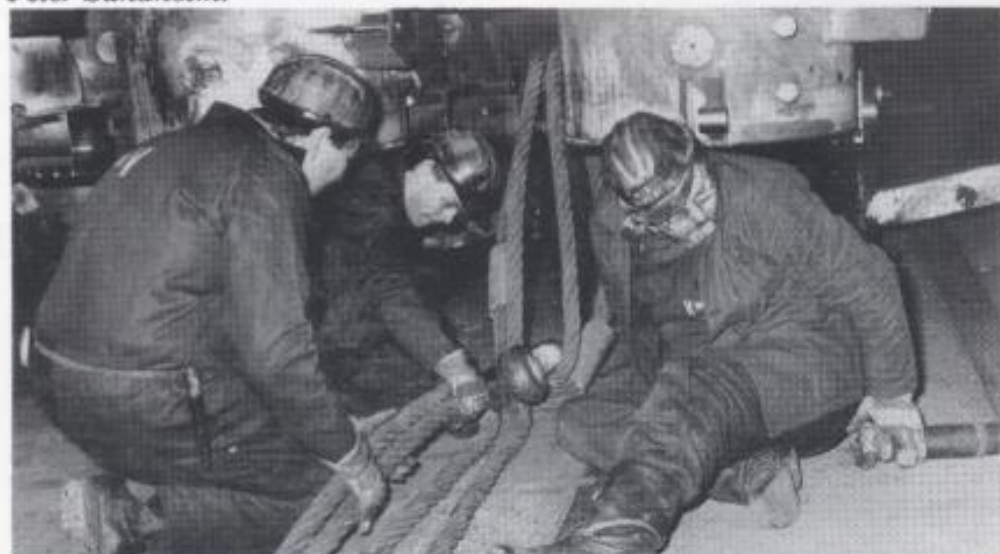
Här pågår kopplingsarbete under ubåtspaket inför vändning. Fr v Bengt Pettersson, Paul Svensson och Per-Åke Karlsson.
