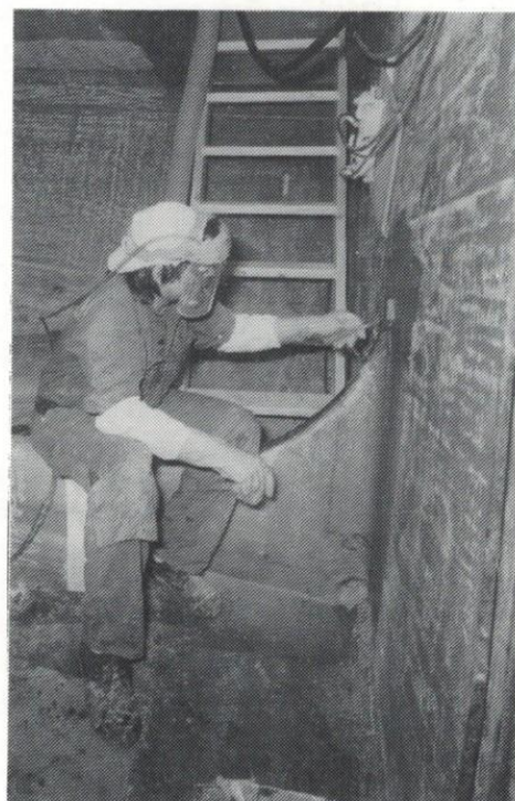
Jan Karlsson utför lamineringsarbete i styrmaskin.
