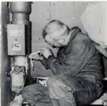
Sven Nedfors, rörverkstaden utför isoleringsarbeten.
