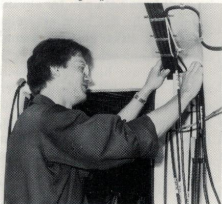
Göran Karlsson utför kabeldragning.
