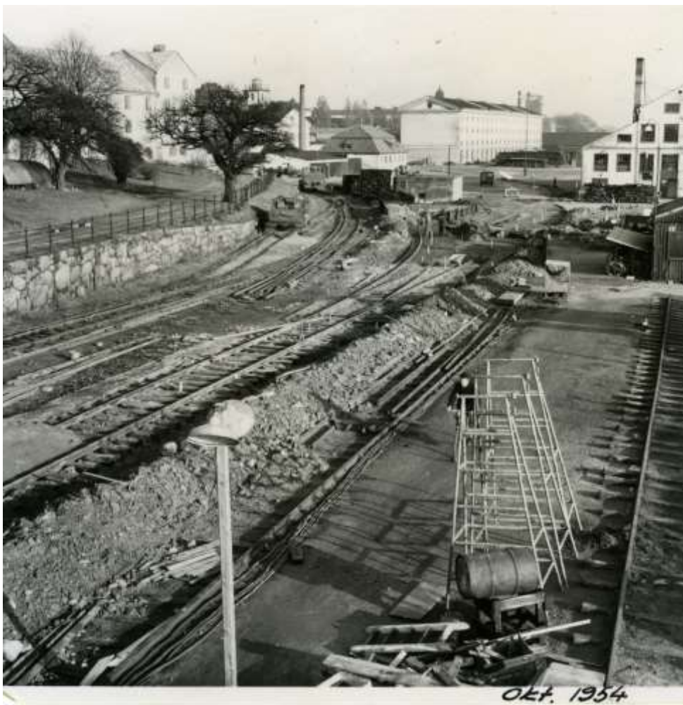
Banarbete vid Örlogshamnen. I bakgrunden Silverhuset och Tackelkammaren
