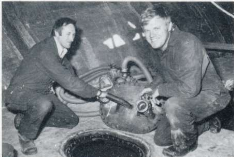
Leif Albertsson och Bengt Olbin förbereder inför provtryckning av tankar.
