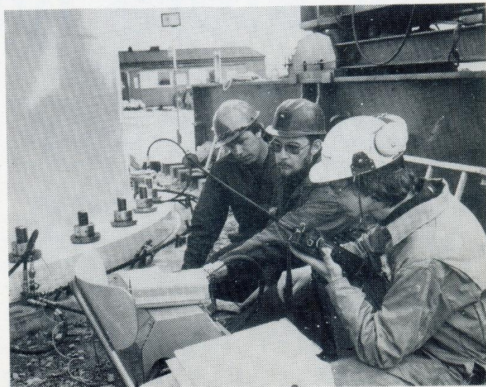
Peter Holmberg, Johnny Svensson och Per Svensson övervakar åtdragningen av bultar till tornfästet i fundamentet.
