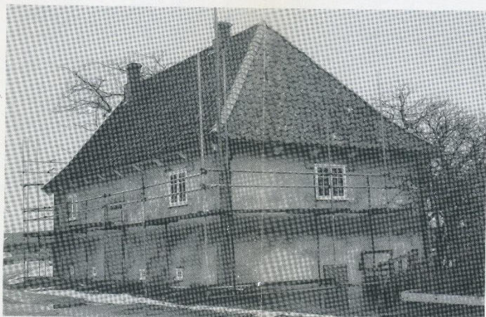
Corps de Garde, Lindholmsvaktens, Vaktstugan-kärt barn har många namn. Byggnaden som uppfördes redan 1624-26 i anslutning till Polhemsdockan, har restaurerats från golv till tak. Viss putsning återstår.
