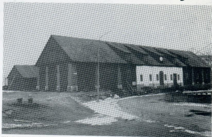
"Knäskjul" är beteckningen på den här byggnaden, som torde vara uppförd i början på 1800-talet. Byggnaden har använts som arbetsbod och materialförråd, där arbetsbänken kvarstår.
