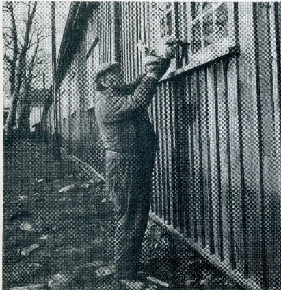
I Repslagarebanan pågick verksamhet från 1696 fram till 1960. Delar av syllen har reparerats och en bit av vägen har sänkts för att hindra vattenrinning mot syllen och de nedre väggpartierna. Ove Johansson utför här en del av de återstående målningsarbetena. - Fina jobbet, tycker han.
