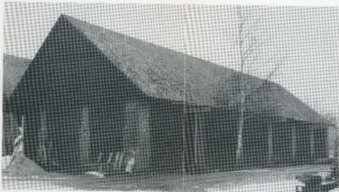
I Fyrkanten, ett gammalt förrådsskjul, har man påbörjat en omfattande restaurering.
