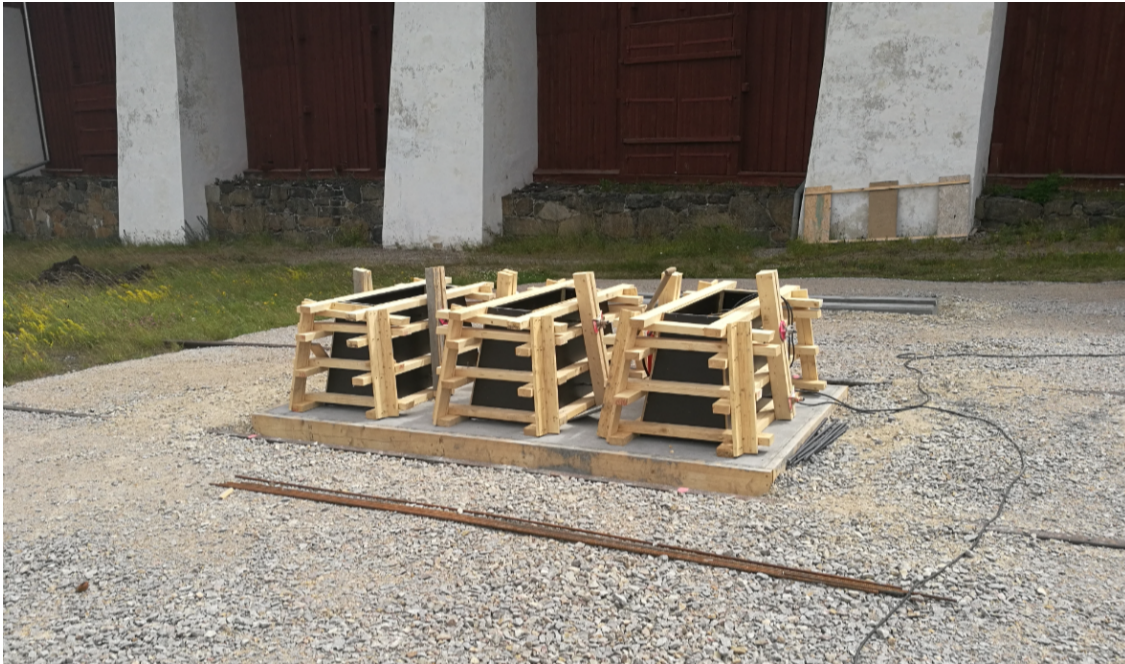
Formarna till de tre kölblocken under byggnation på den gamla stapelbädden vid Wasa skjul
