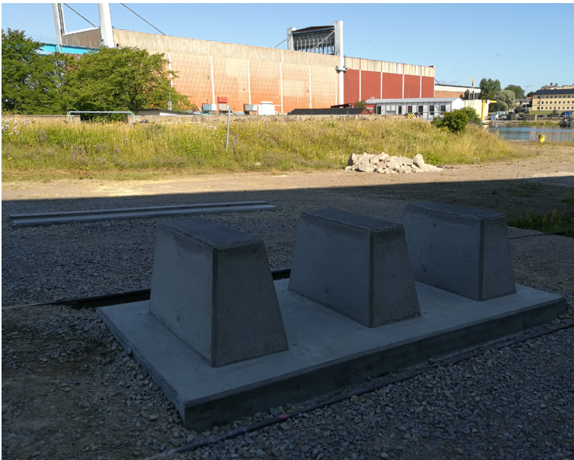
De tre kölblocken i betong som rekonstruktionen ska placeras på.
