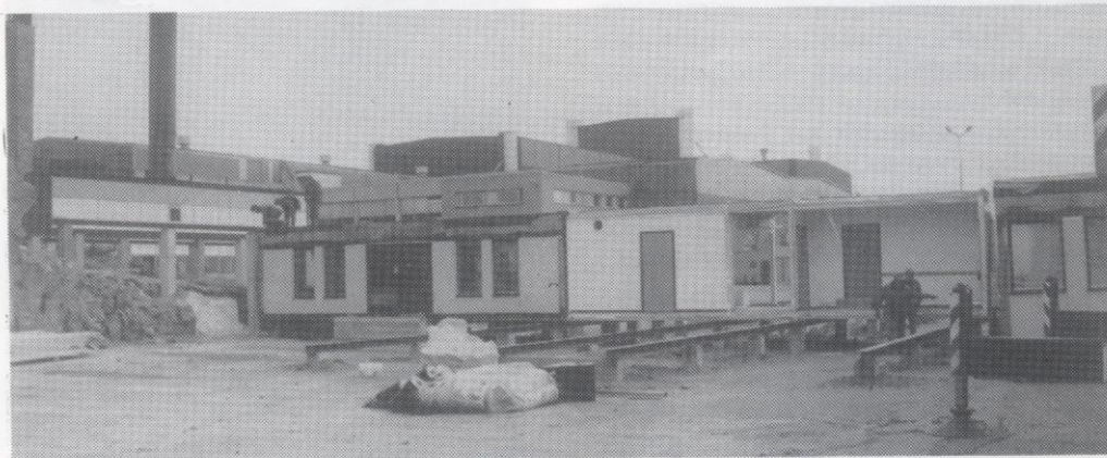
Nu har monteringen påbörjats av den produktionsadministrativa byggnaden, som ska stå klar till semestern.
