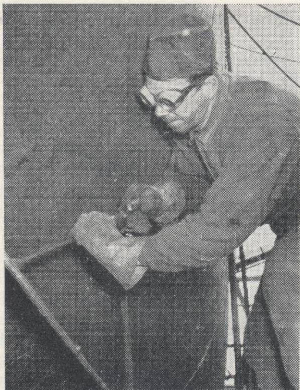
All gammal färg och rost skall bort. Utrustningsarbetare A. Pettersson sköter rosthackan.
