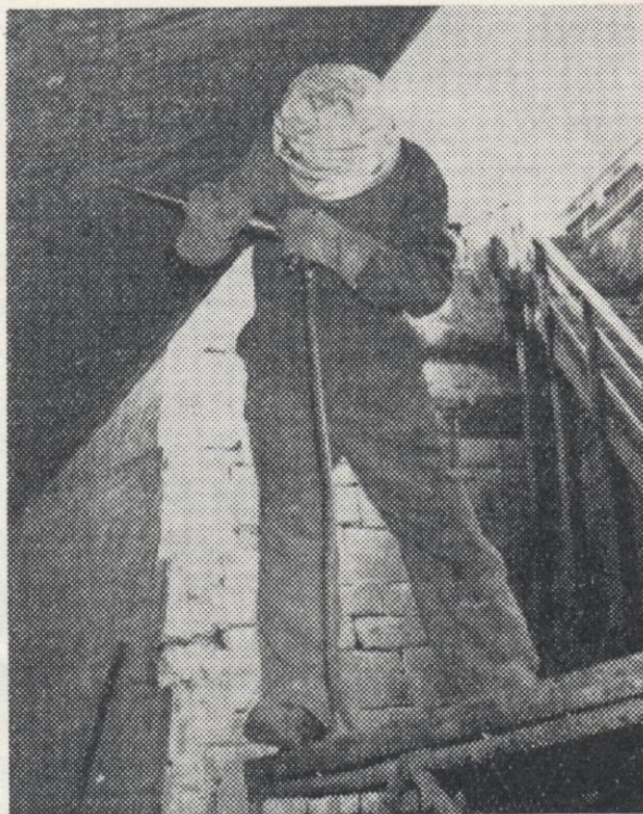
Under skyddshuvan döljer sig en ut- rustningsarbetare, som rosthackar en jagares botten.
