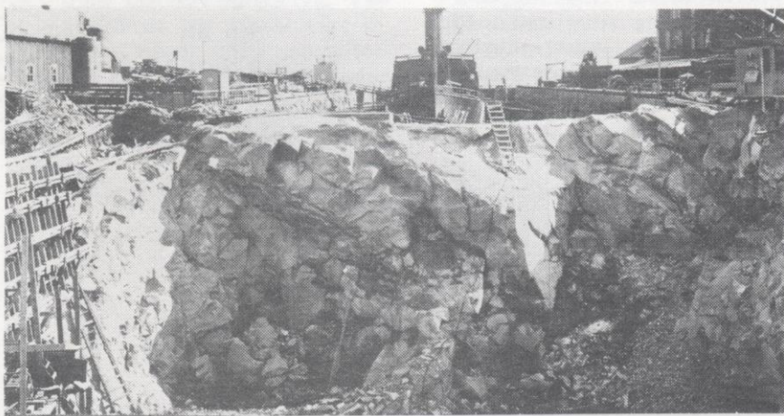
Året var 1945. Fortfarande rådde ofred i världen och för att kunna utnyttja dockan även under förlängningsarbetena så gjorde man som på bilden. Lät den gamla spetsen sitta kvar till den nya biten i stort sett var klar att ta i bruk. I dockan ligger här en av de inmöntrade hjälpkryssarna.
