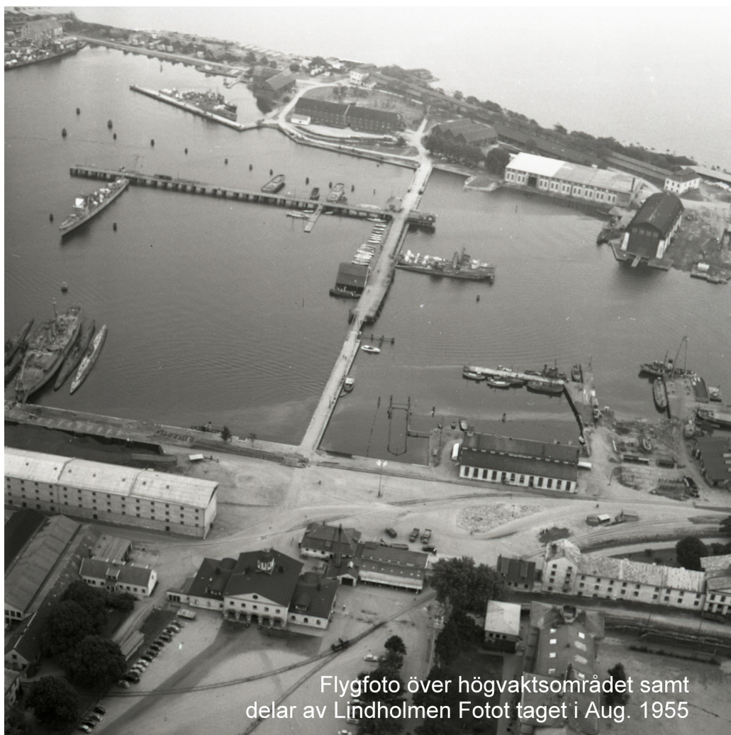
Flottans skeppsbro 1955 då kranboden fortfarande fanns kvar före branden 1969
